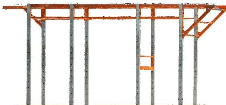
Figura 45: Levantamento fotogramétrico terrestre da estrutura metálica na Maia.
